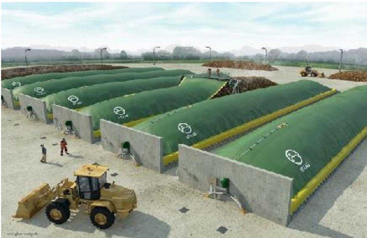
Рис. 4. Стационарная площадка открытого компостирования с тентами из мембраны для накрытия компостных буртов<sup>3</sup>
