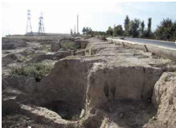
Рисунок 2.7. Эрозия лессовой породы в результате утечки воды из оросительного канала (Андижан).
